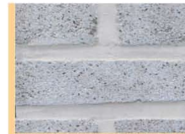
Joint plein reprenant la couleur de la brique.
