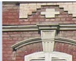
Éliminer les efflorescences superficielles par nettoyage doux.
