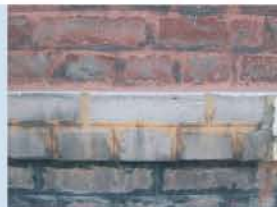
Effacer les traces grises de pollution qui ternissent la façade.
