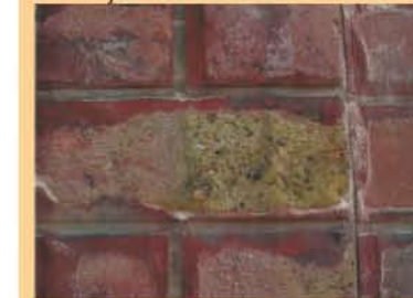
Joints beurrés repassés au fer à joint : sa couleur est en ton sur ton avec celle de la brique. Le passage du fer restitue l'orthogonalité de la brique qui disparaît sous le beurrage.
