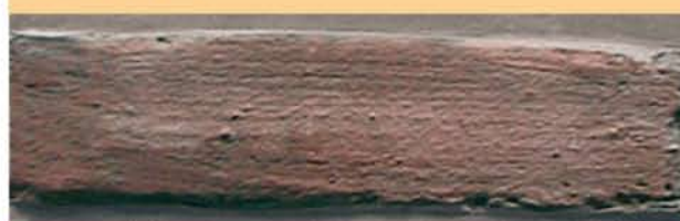
3- Lorsque la brique est trop abîmée (comme sur le cas 1), le badigeon à la chaux peut la protéger, tout en respectant ses qualités esthétiques (sa forme, sa couleur, son appareillage).
