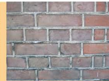
Joint saillant, traditionnellement clair
