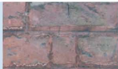
Joint beurré en ton sur ton, repassé au fer.
