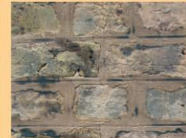
Joint saillant, traditionnellement clair
