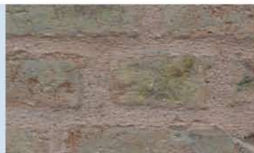
Joint plein en ton sur ton.
