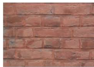
Le badigeon de chaux + ou - dilué colore en transparence et protège la brique et les enduits de chaux.
