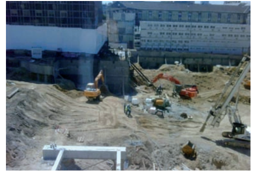
Le chantier : le terrassement
