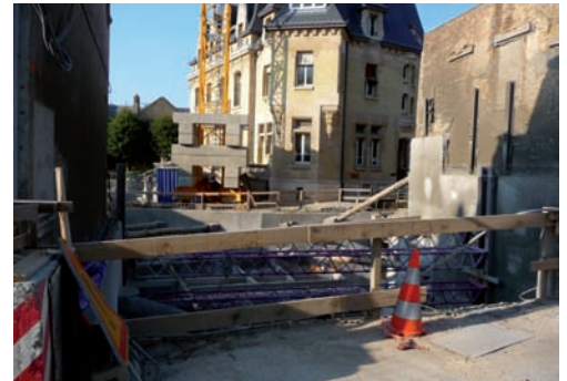
Le chantier : les fondations
