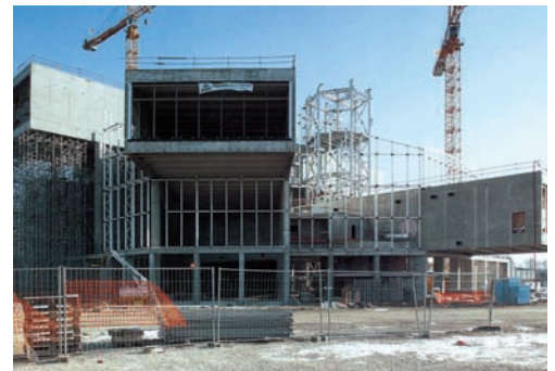
Le chantier : le gros œuvre
