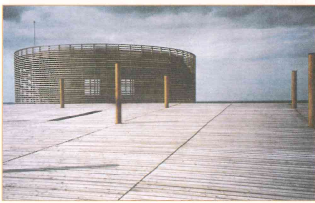
Vues de la toiture
