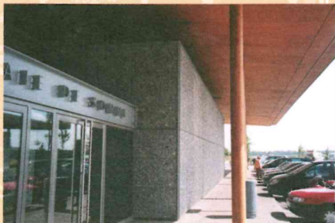
Vue sur l'entrée du bâtiment de service
