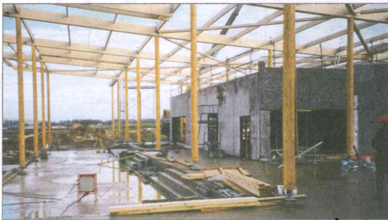
Chantier (bâtiment de service)
