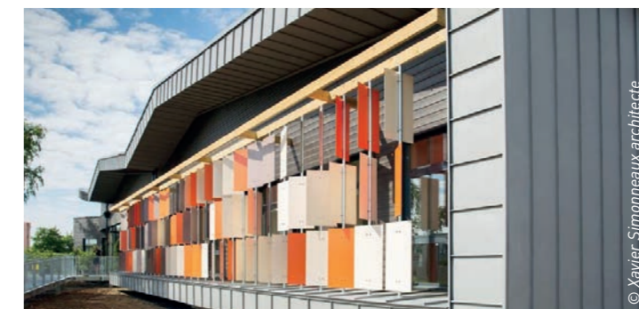
Bureaux de la Fédération Française du Bâtiment (FFB). Construction bois et paille à haut niveau de performance énergétique à Compiègne (60). Xavier Simonneaux architecte
