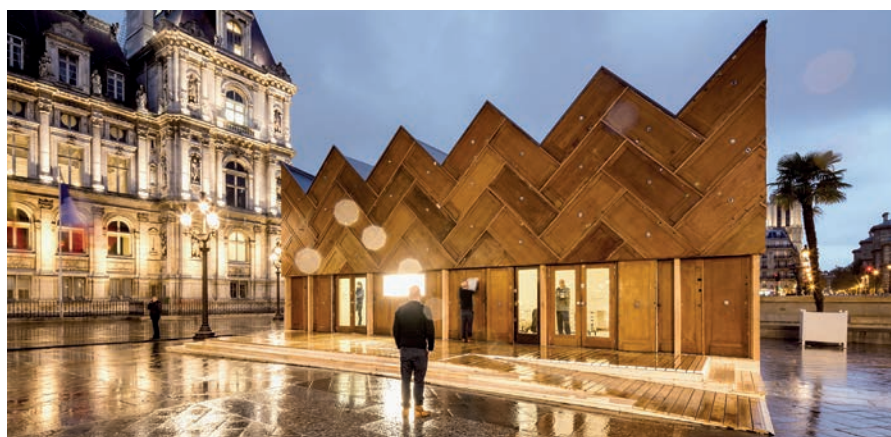
LE PAVILLON CIRCULAIRE - Encore Heureux Architectes, 2015
