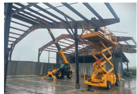
Etapes de la dépose soignée de structures bois en perspective de la réalisation du bâtiment exemplaire où siègeront les entreprises Lemaître © Lemaître Réemploi
