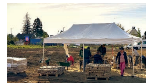
Villers-Bretonneux : AMSOM Habitat réemploie les briques des chantiers de démolition d'une ancienne maison de maître. Le réemploi de ces 27 000 briques est pris en charge par l'entreprise Réempro © AMSOM-Habitat
