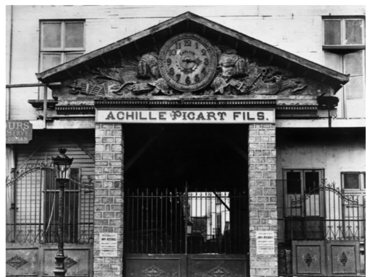
1883 - Paris - Après l'incendie du Palais des Tuileries (1871), l'entrée des Ateliers Achille Picard (démolisseur) se voit surmontée d'un fronton qui en est issu © Walter Daran, Getty Images
