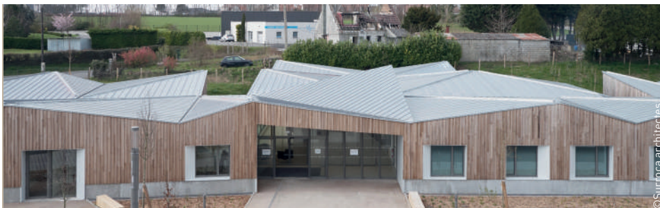
Maison de santé pluriprofessionnelle à Woincourt et son jardin médicinal : une architecture écologique, fonctionnelle et accueillante pour rapprocher les services médicaux des habitants.
