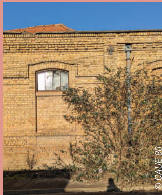
Friche Mailcote (Villers-Bretonneux) : murs maçonnés en briques, pérennes et réemployables
