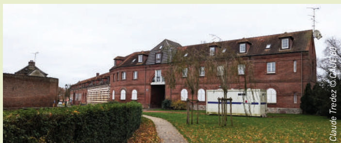
Communs du château transformés en logements et bibliothèque
