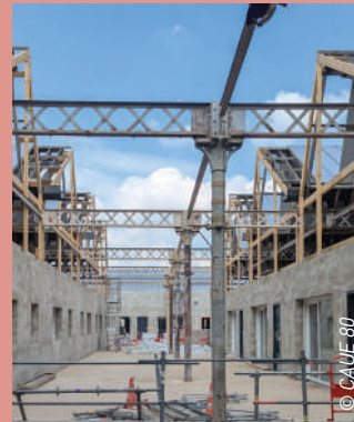
Friche Maréchal (Rosières-en-Santerre) : trame structurelle métallique adaptée à des programmes variés
