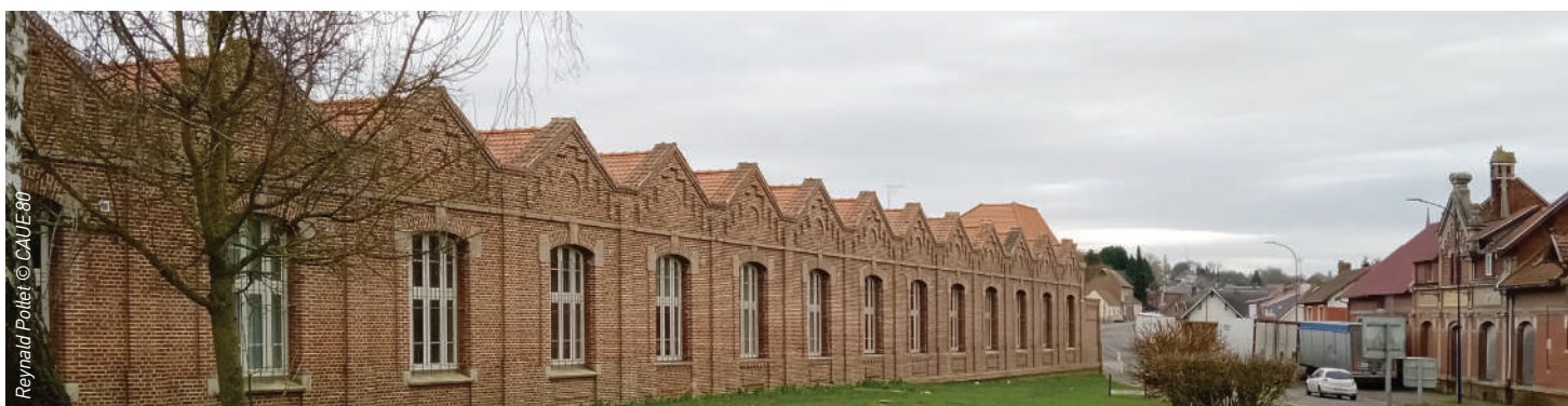
Ex-friche Rosenlaw à Beauval : un témoin de l'industrie textile dans la Somme, conservé pour partie et aujourd'hui transformé en logements.
